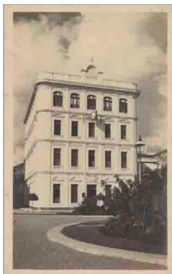
Figura 4: Prédio da Western Telegraph, início do século XX
