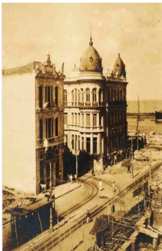
Figura 8: Avenida Rio Branco, Bairro do Recife 1920, nota-se o traçado dos trilhos e a presença do bonde elétrico
