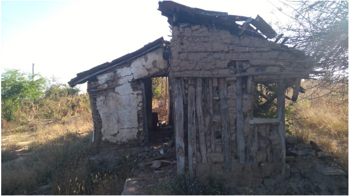
Figura 25- casa de taipa - Sítio Montevidéu-Caetés-PE. Fonte: acervo Vale do São José – fotografia, Alexandre Teixeira, 2020.
