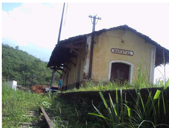
Figura 63 - Estação ferroviária de Maraial, 2010
