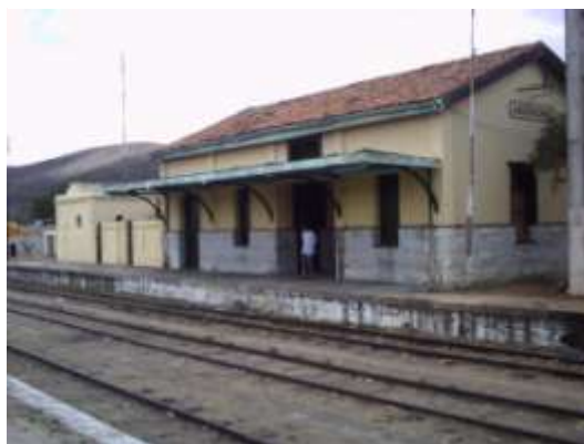
Figura 19 - Estação ferroviária de Arcoverde, 2009
