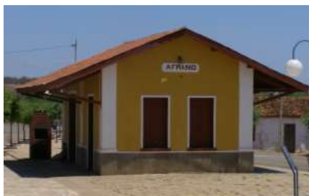
Figura 81 - Estação ferroviária de Afrânio, 2009
