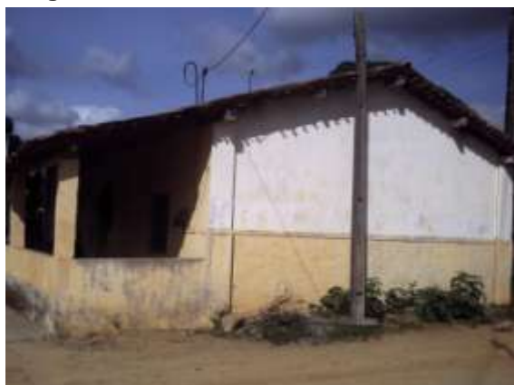
Figura 68 - Estação ferroviária de Progresso, 2013
