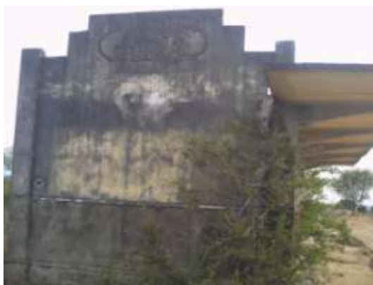
Figura 32 - Estação ferroviária de Felipe Camarão 2012
