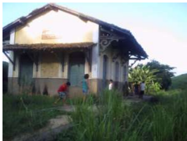
Figura 62 - Estação ferroviária de Frei Caneca, 2010
