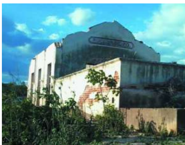
Figura 23 - Estação ferroviária de Pinto Ribeiro, 2015
