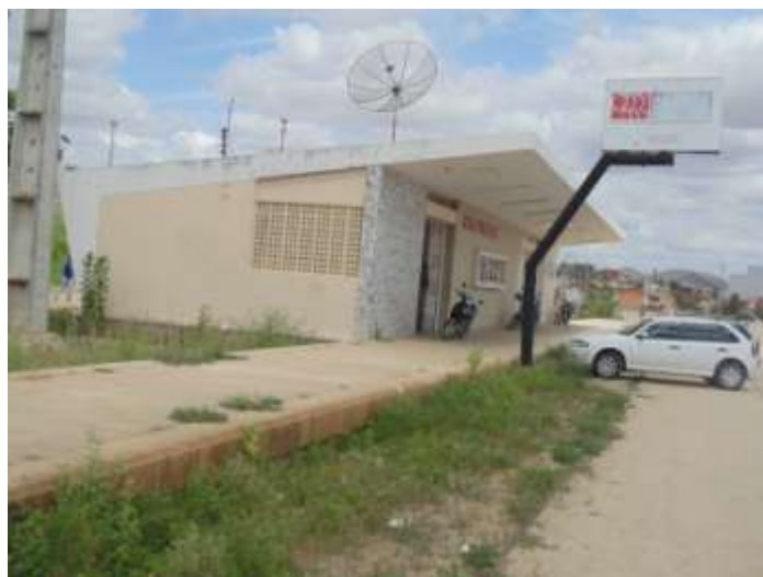
Figura 37 - Estação ferroviária de Salgueiro, 2014.
