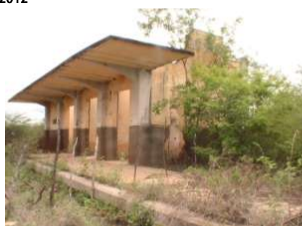
Figura 30 - Estação ferroviária de S. Serafim, 2012
