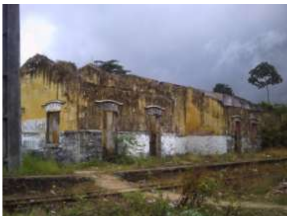
Figura 40 - Estação ferroviária de Camaragibe, 2009
