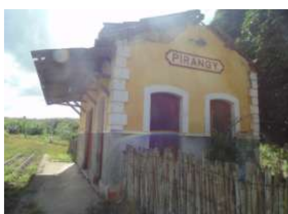
Figura 59 - Estação ferroviária de Pirangi, 2015
