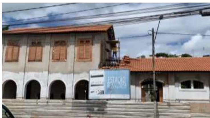
Figura 82 - Obras de restauro da estação ferroviária de Moreno em 2020
