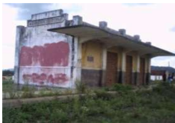
Figura 24 - Estação ferroviária de Albuquerque Né, 2010
