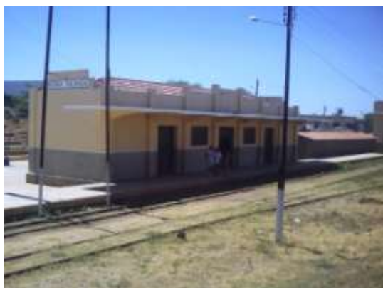
Figura 31 - Estação ferroviária de Serra Talhada, 2009
