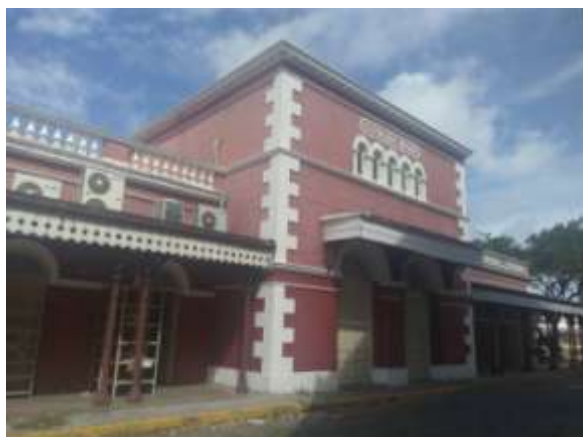
Figura 38 - Estação ferroviária do Brum, 2020
