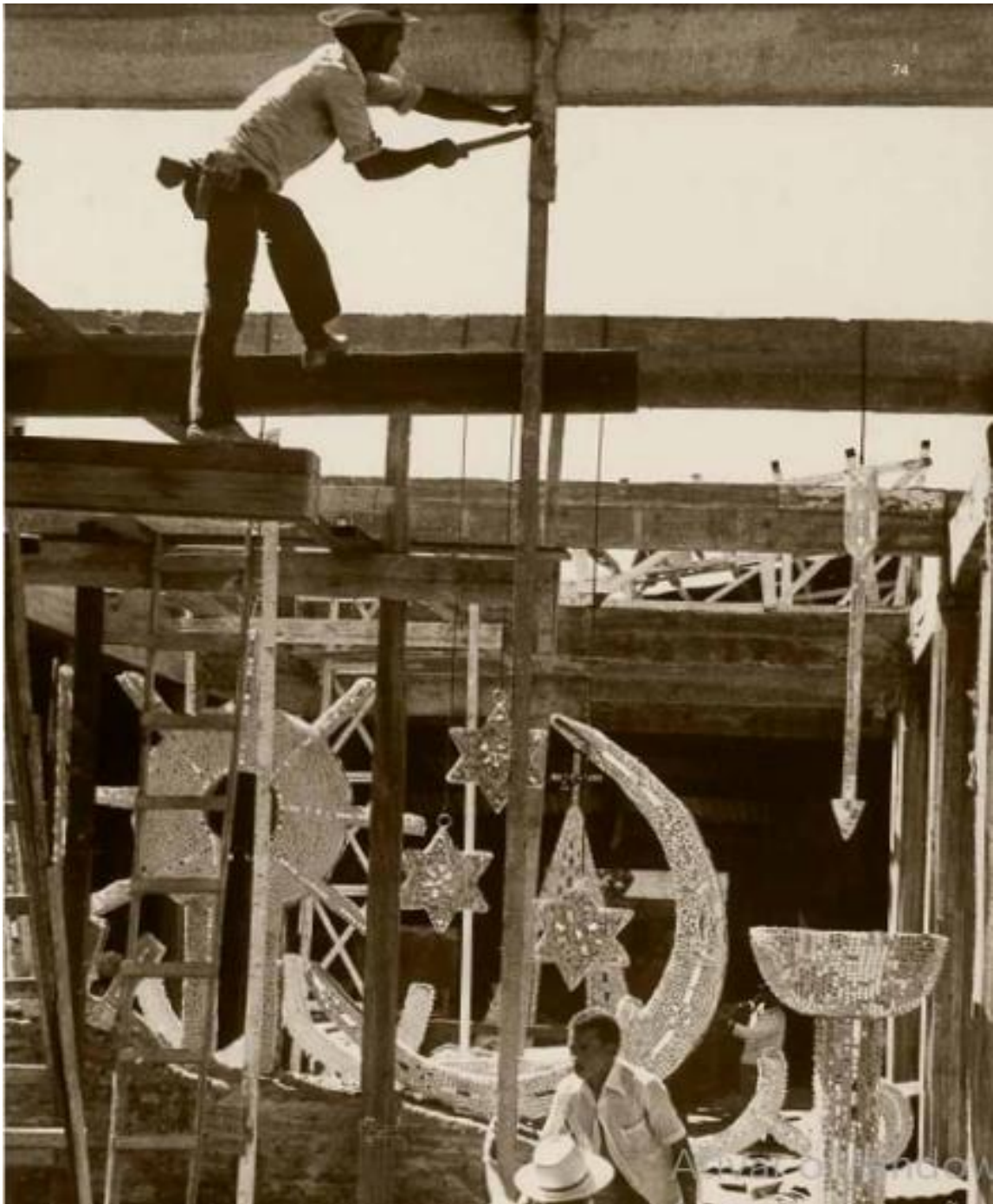
Figura 13 – Construção do Templo-Mãe. Imagem da construção do Templo-Mãe de Alvenaria.
