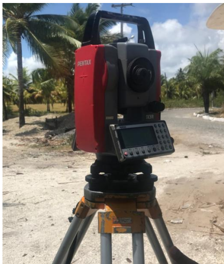
Figura 20 - Estação Total para levantamento das áreas.
