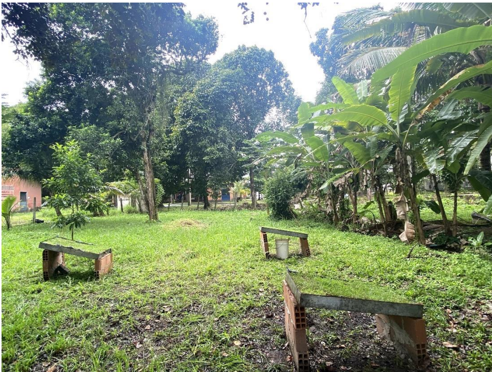
Figura 16. Perspectiva das unidades experimentais ou protótipos no campo, consistindo de paredes em alvenaria e telhados verdes em chapas metálicas. Fonte: Foto da autora.
