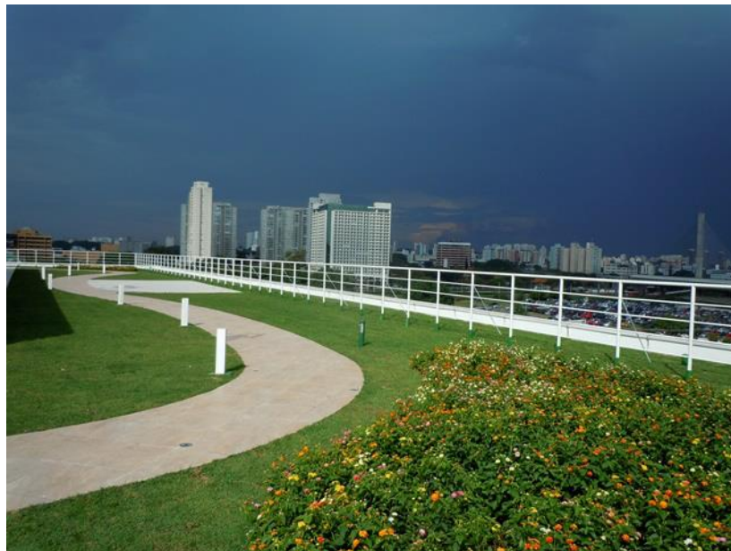
Figura 1 – Telhado Verde. Fonte: https://arvoresdesaopaulo.wordpress.com/
