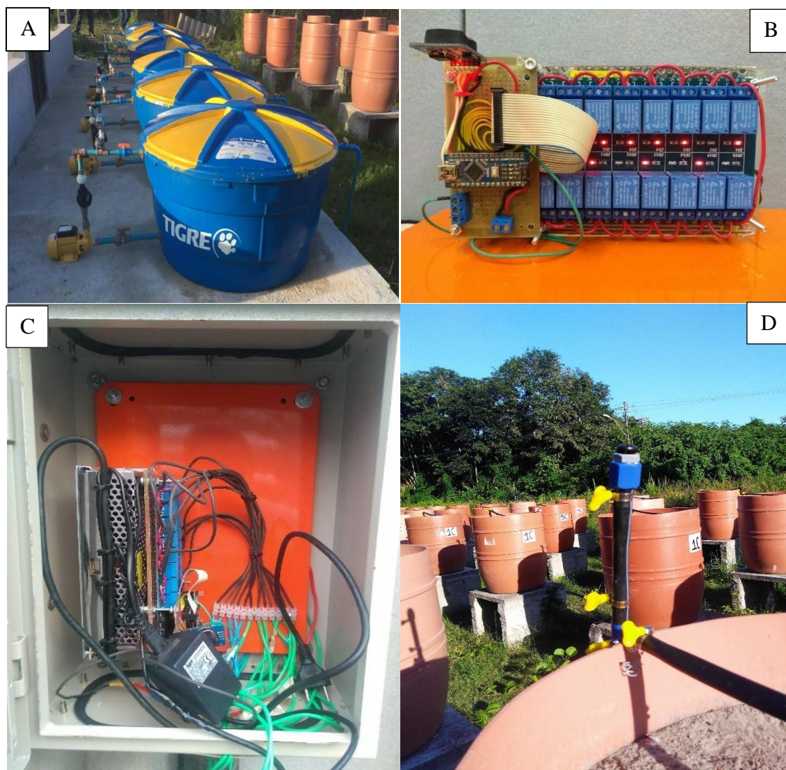
Figura 5. (A) Seis conjuntos de reservatório com capacidade de 500 L, filtro de disco e eletrobomba responsáveis pela distribuição das soluções salobras; (B) Controlador de válvulas solenoides composto por arduino com detalhe da distribuição dos conjunto de relés; (C) Painel de controle responsável por comandar a abertura e fechamento das válvulas solenoides; (D) Válvula antivácuo rosca 1/2”
