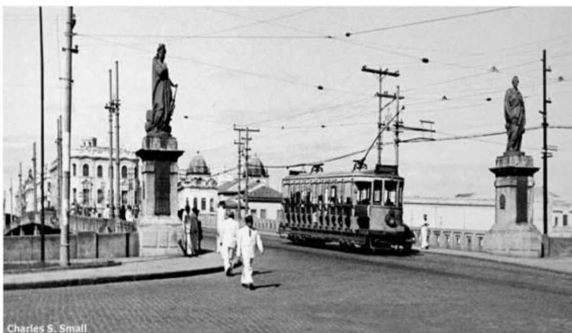
Figura 22 – Ponte Maurício de Nassau e as linhas de bonde (1943)
