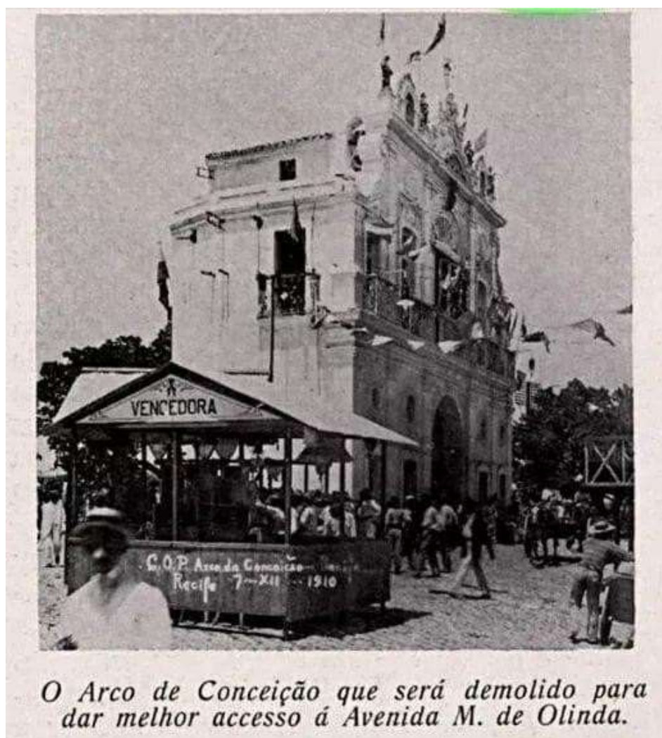
Figura 14 – Arco da Conceição, vista lateral
