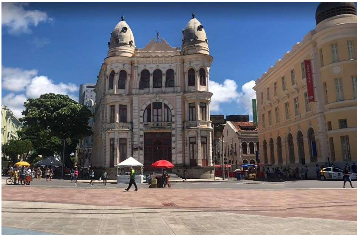
Figura 13 – Prédio da ACP visto da Praça Rio Branco
