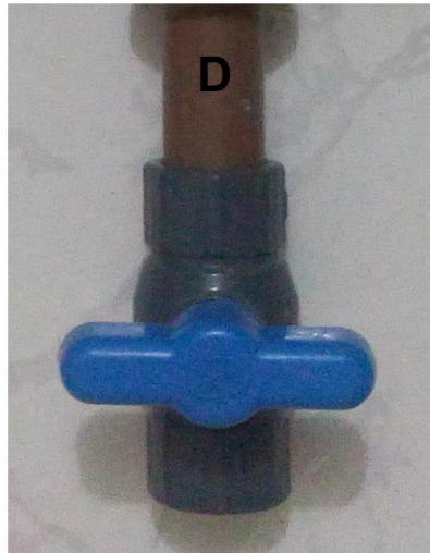
Figura C.34- Braço do registro de expurgo.
