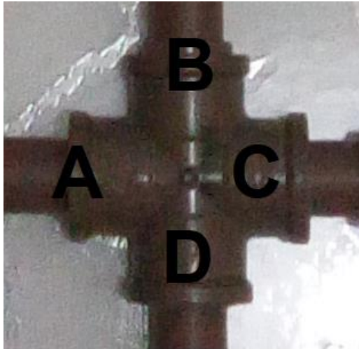
Figura C.32- Cruzeta interligadora.
