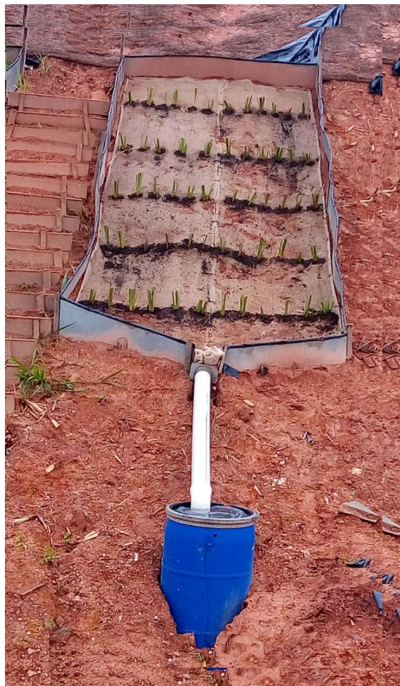
Figura 5 - Parcela hidroerosiva instalada com coletor.
