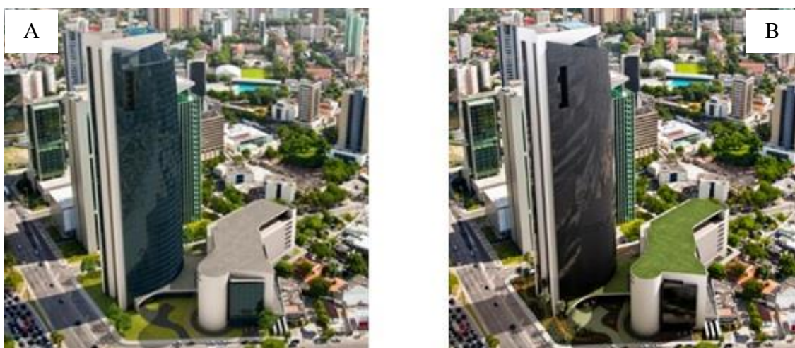
Figura 6: Edifício Garagem Empresarial Charles Darwin. Foto antes da implantação do telhado verde (A) e após implantação do telhado verde (B). Fonte: Rio Ave, Empresarial Charles Darwin.
