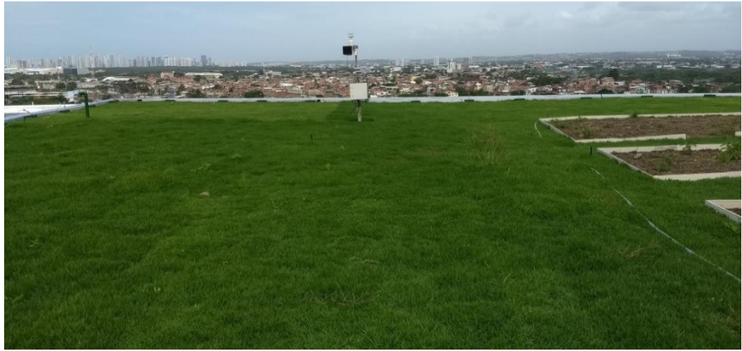
Figura 1: Telhado verde extensivo formado por grama esmeralda. Fonte: Arquivo pessoal, 2017.
