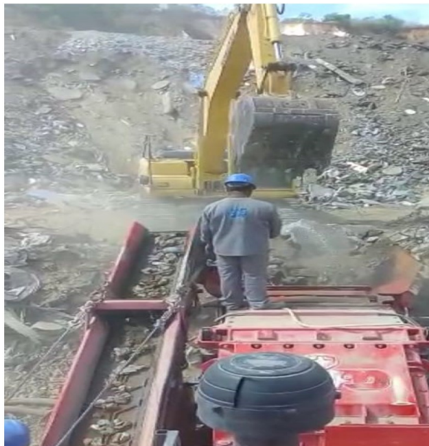
Foto 4- RCC sendo colocado no Britador.
