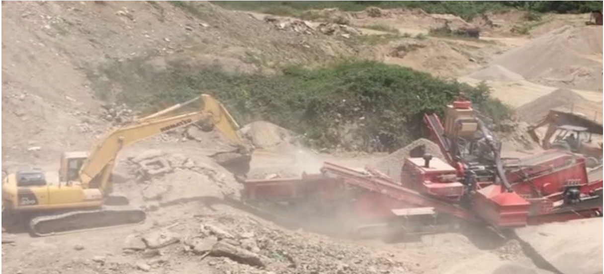
Foto 3- RCC sendo colocado no Britador.
