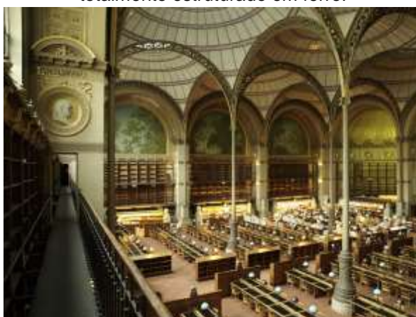
Figura 11 – Interior da Biblioteca de Sainte-Geneviève. Projetada pelo arquiteto francês Henri Labrouste e construída entre os anos 1838 e 1850, a biblioteca foi o primeiro edifício não industrial totalmente estruturado em ferro.
