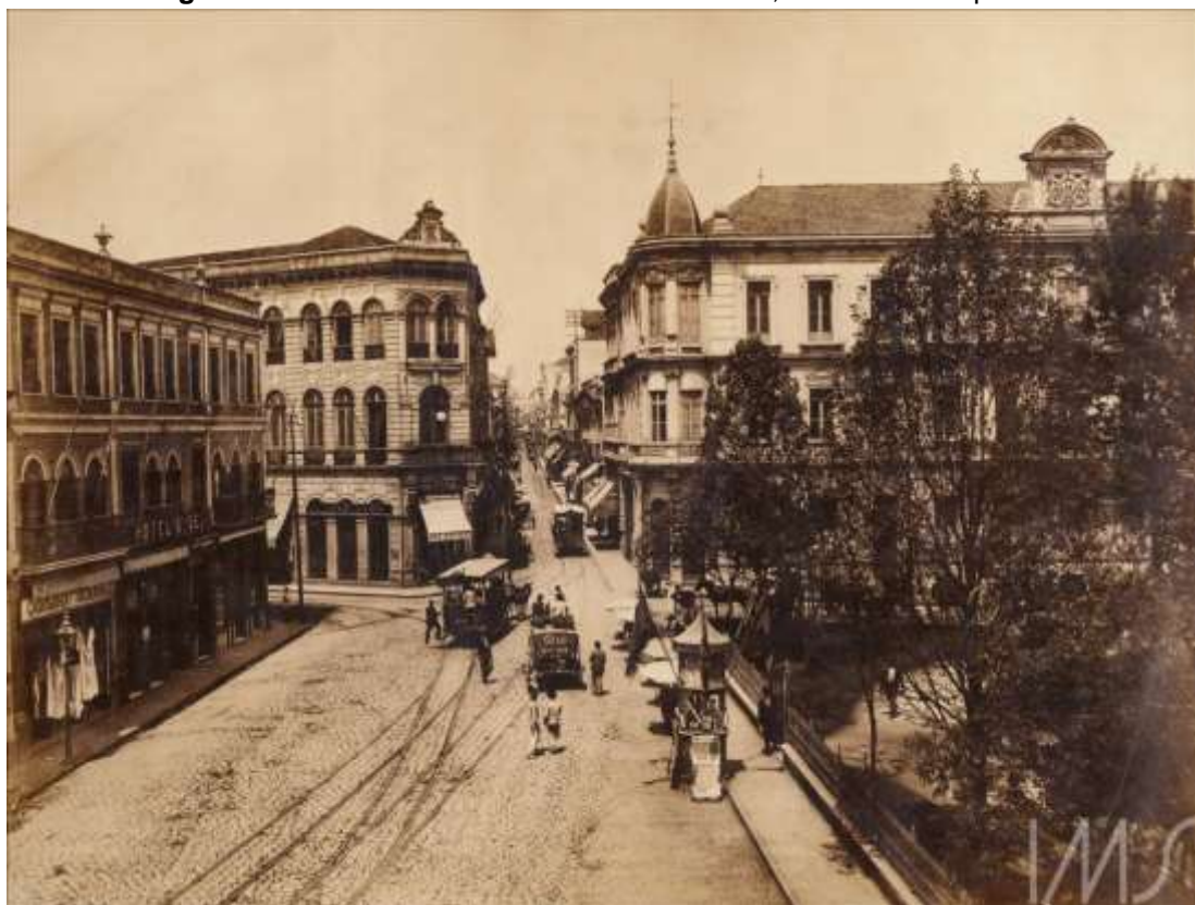
Figura 22 – Edifício do Grande Hotel Paulista, ao fundo à esquerda.
