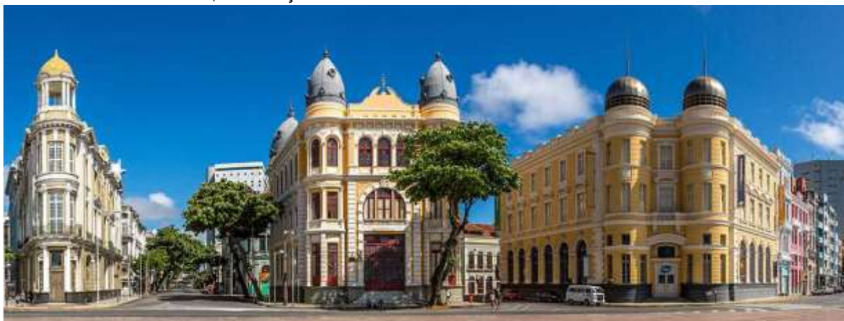
Figura 48 – Edificações ecléticas na Praça Rio Branco. Da esquerda para a direita, antiga sede do Santander Cultural, Associação Comercial de Pernambuco e o edifício da Caixa Cultural.
