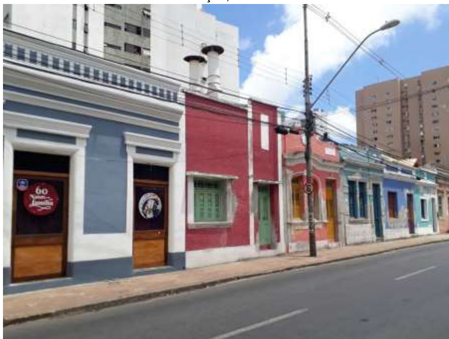
Figura 55 – Conjunto de edificações térreas com fachadas ecléticas na Avenida Rui Barbosa, Graças, Recife.
