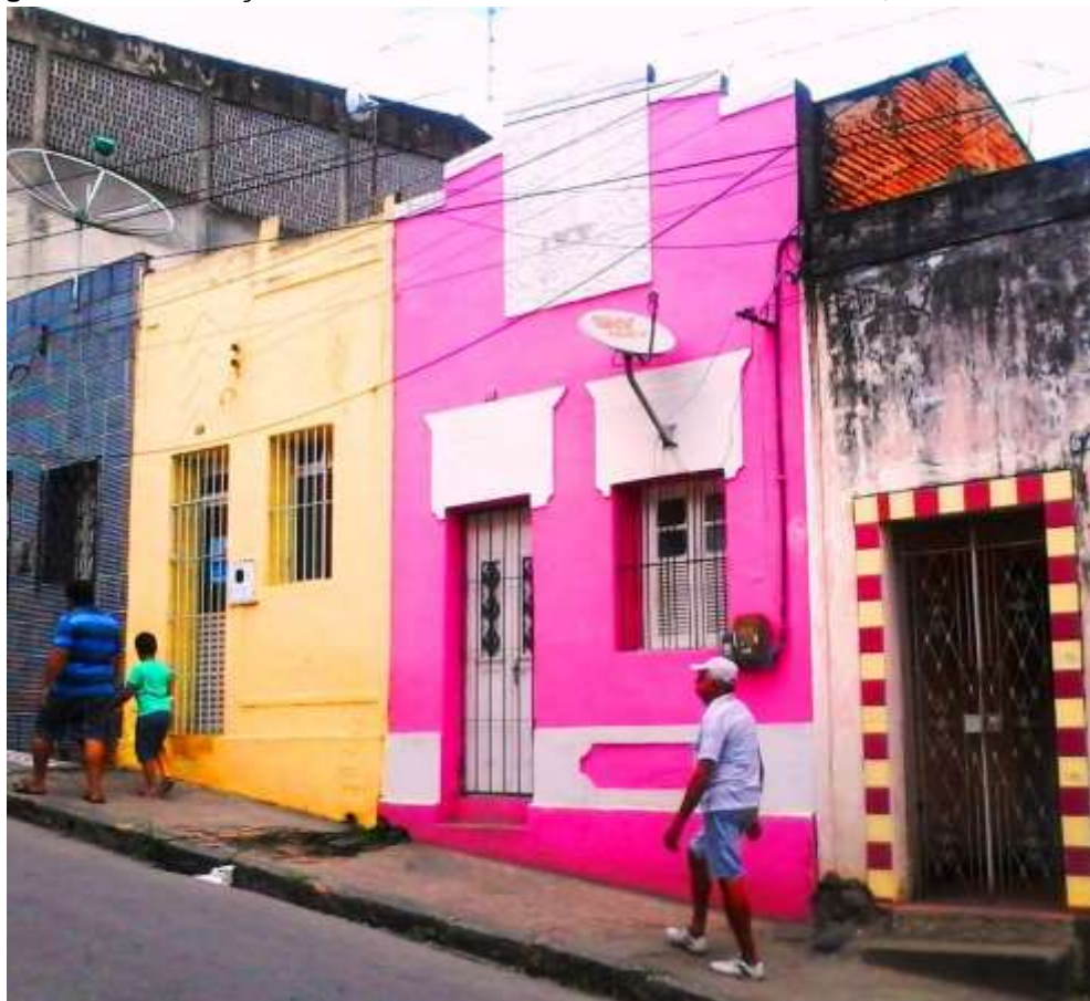
Figura 95 – Edificação no número 61 da Rua Mal. Dantas Barreto, Centro do Cabo.
