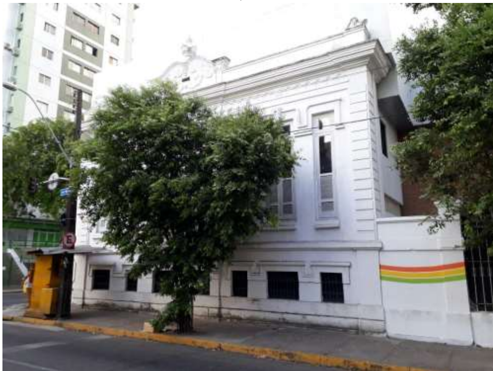
Figura 61 – Casa de porão alto com fachada eclética no nº 105 da Rua José de Alencar, Boa Vista, Recife.
