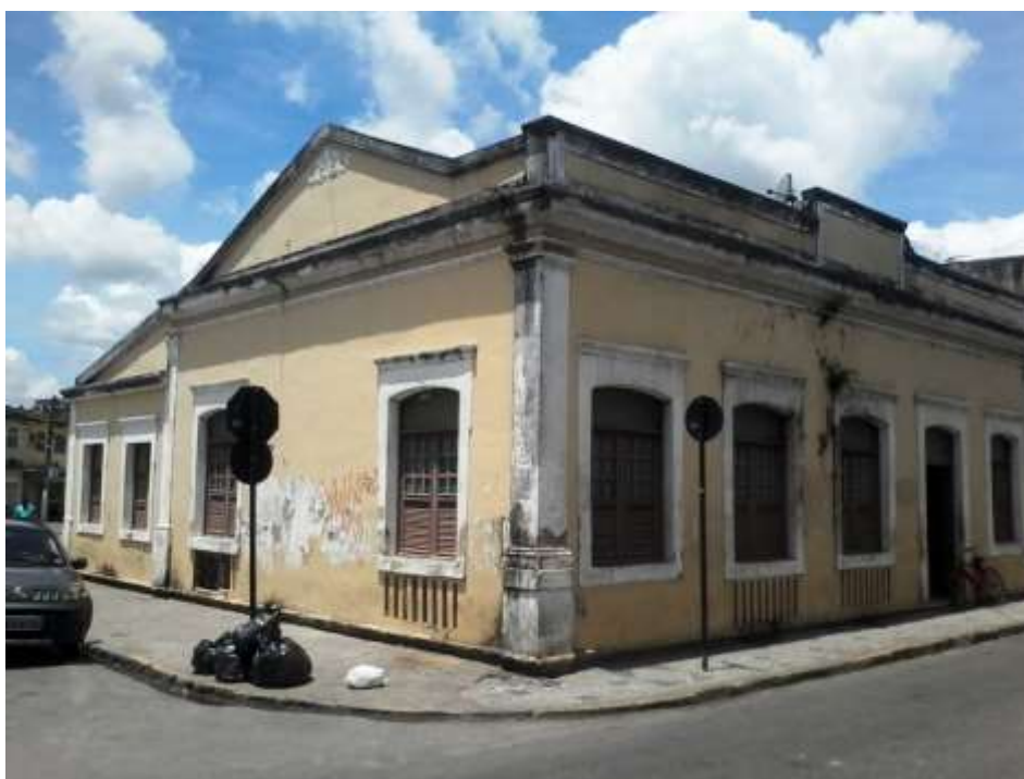
Figura 99 – Edificação eclética na esquina das ruas Teixeira de Sá e Cel. Artur Cisneiros
