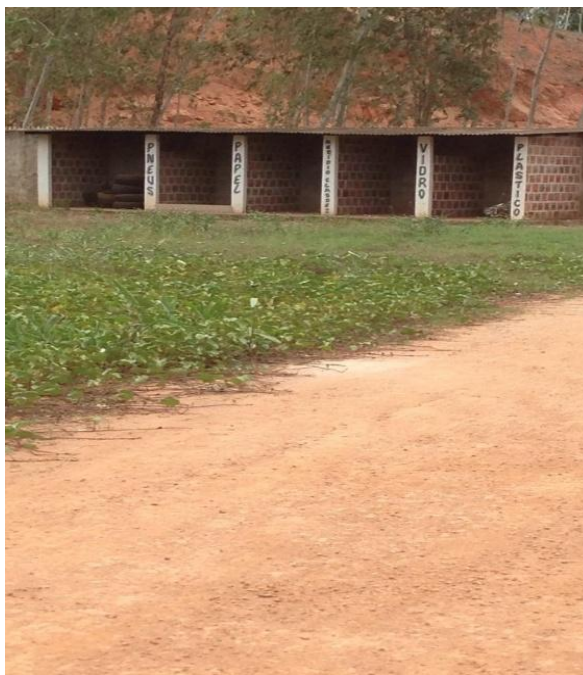
Figura 20 Baias para acondicionamento dos resíduos
