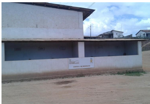
Figura 23. Indústria 11- Baias para acondicionamento dos resíduos
