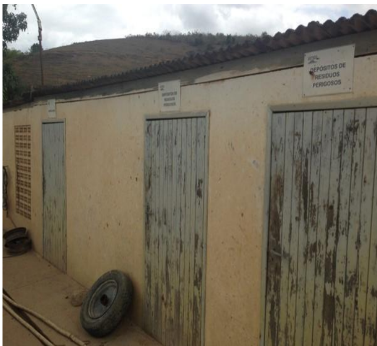
Figura 15. Indústria 5-Armazenamento adequado de produtos químicos
