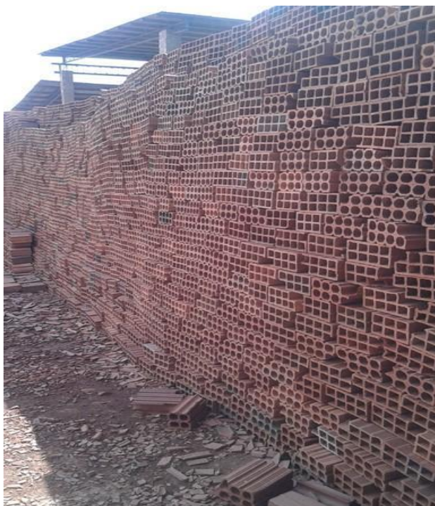
Figura 22 Armazenamento do produto acabado inadequado
