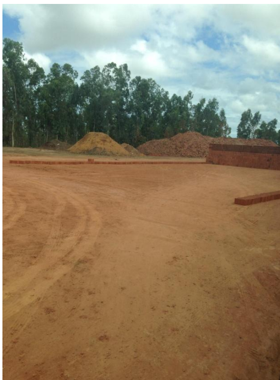
Figura 19. Resíduos de produto não conforme
