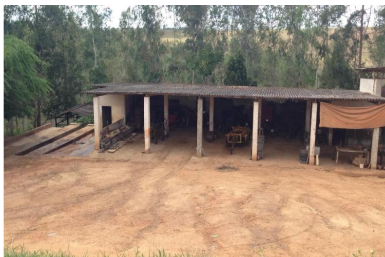
Figura 12 Área de manutenção de veículos e máquinas
