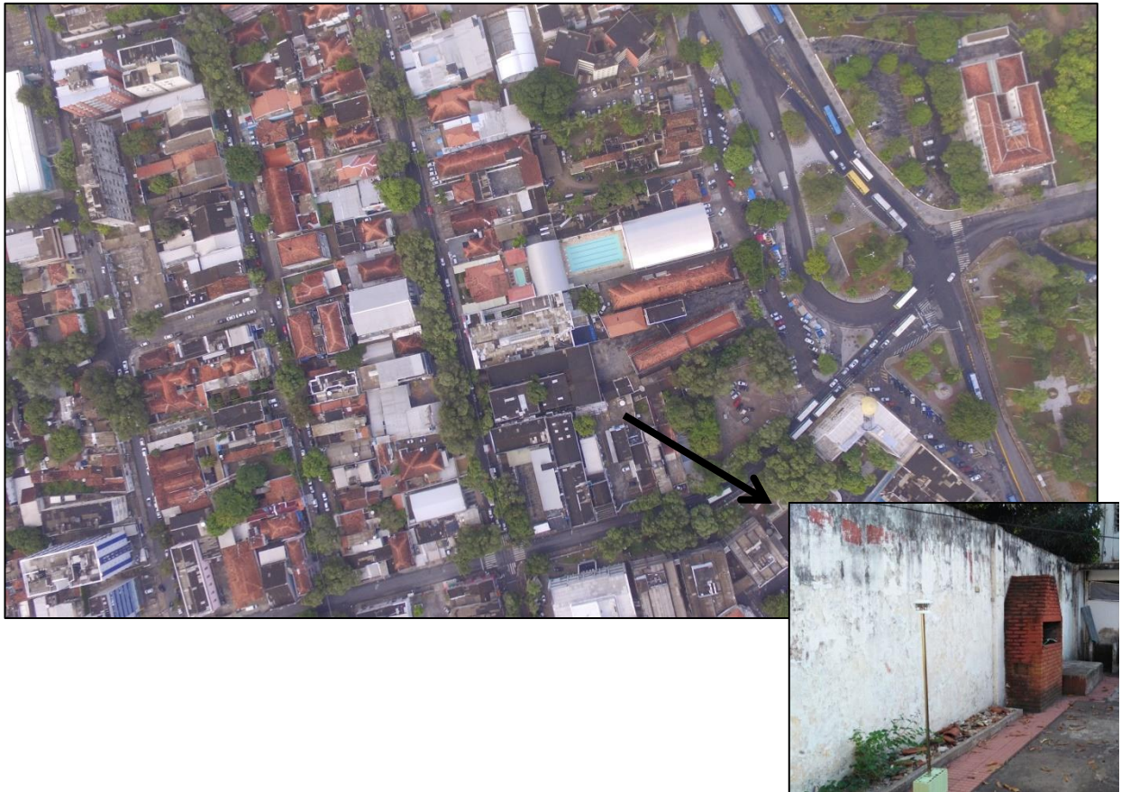
Figura 18 – Vista área do ponto 04 (Boa Vista) e de seu entorno.
