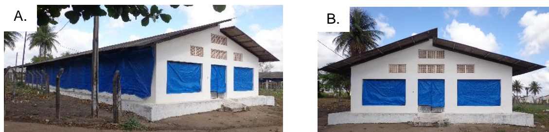
Figura 1. (A) Vista externa longitudinal e (B) transversal do galpão experimental para o alojamento das aves, Carpina – PE, 2017.
