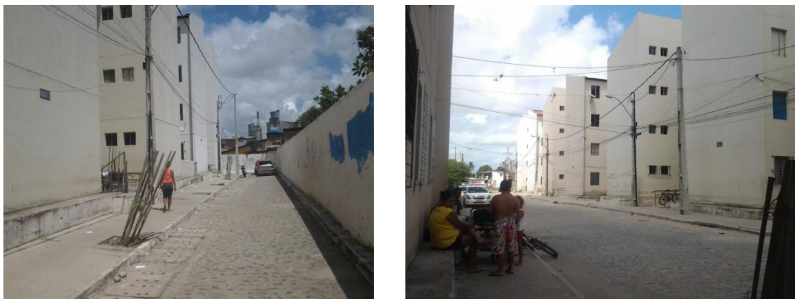
Foto 5: Conjunto Habitacional RPA 2 Beira Rio . Arruda. Entre os edifícios e os acessos de veículos
