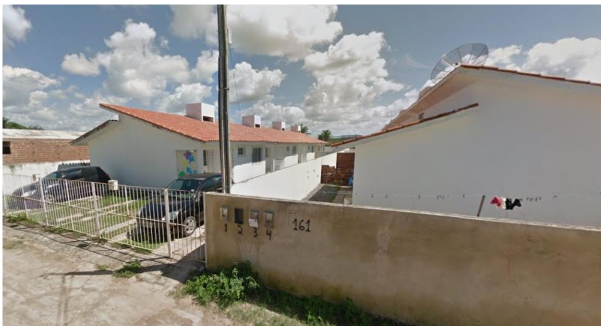
Foto 20: Fachada Lateral LESTE Conjunto
