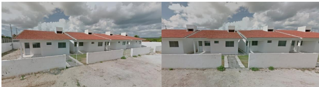
Foto 8: Fachada do Conjunto Habitacional (antes da ocupação)
