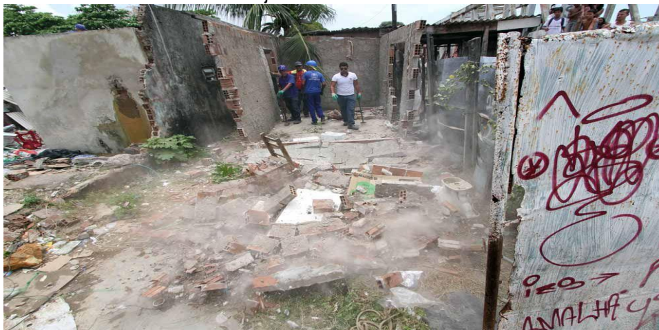
Figura 10: Processo de demolição das antigas moradias, - a imagem retrata a situação em que se as famílias moravam antes de habitar no Conjunto Habitacional RPA 2 Beira Rio . Arruda.
