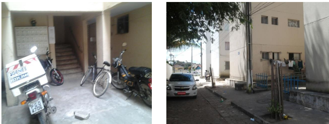
Foto 4: Conjunto Habitacional RPA 2 Beira Rio . Arruda. Acesso dos apartamentos
