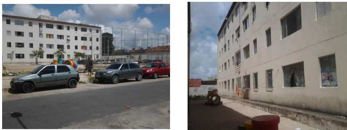
Foto 6: Conjunto Habitacional RPA 2 Beira Rio -Arruda Vista da rua para o Conjunto
