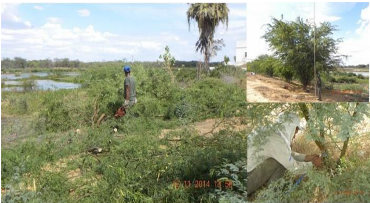
Figura 2 – Limpeza da área com a supressão dos indivíduos de Algaroba na Estação Experimental de Belém de São Francisco – PE.
