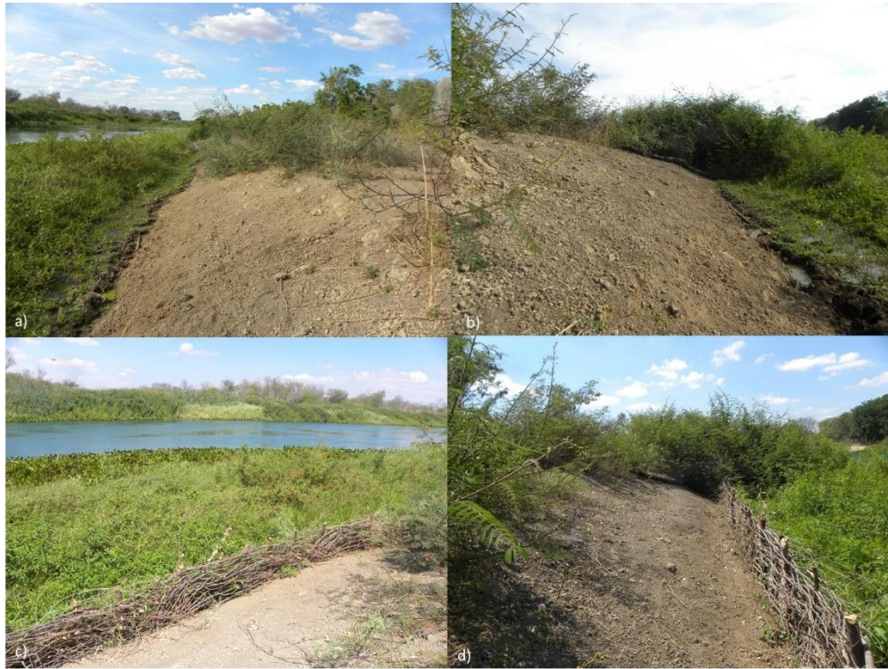
Figura 14 - Trança viva construída no mês de Novembro/2015. Onde: momento inicial da implantação (a, b) e após um mês da conclusão da obra em dezembro/2015 (c e d).
