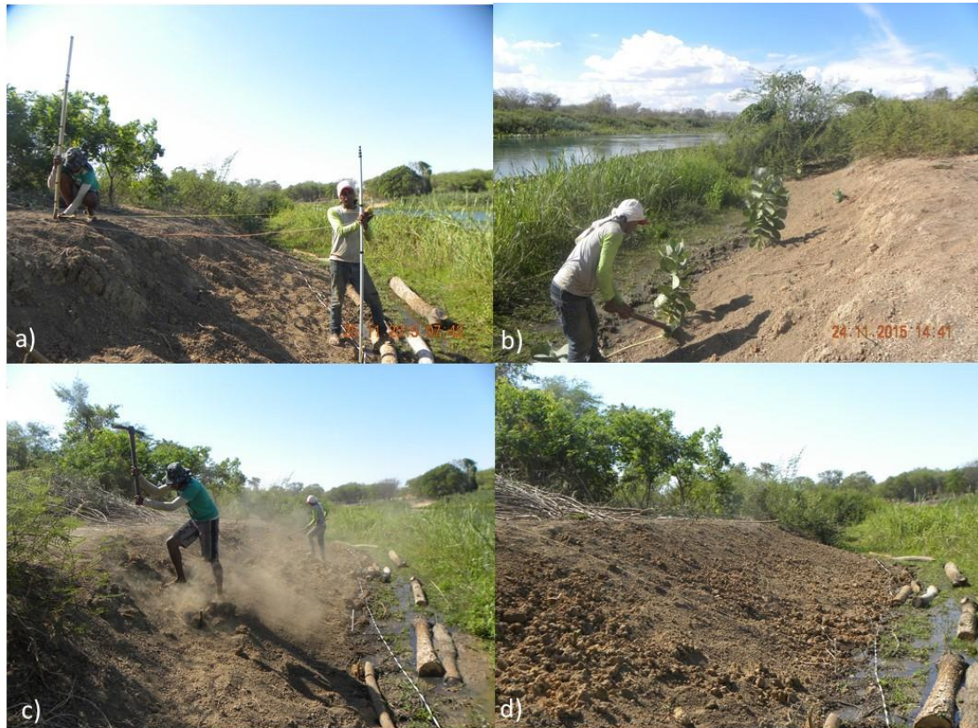
Figura 4 - Etapas de preparação do terreno com remodelagem do talude para construção da Esteira viva, em Belém de São Francisco – PE. Onde: a) medição da declividade do terreno; b) supressão de indivíduos de algodão-de-lã ( Calotropis procera - espécie exótica); c) remodelagem do talude e d) talude com inclinação redesenhada.
