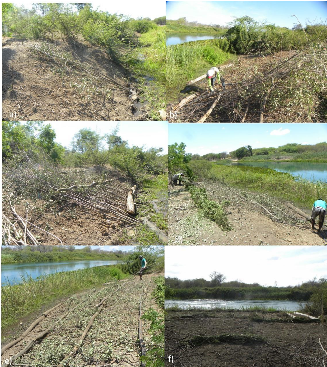
Figura 6 - Construção da Esteira viva as margens do rio São Francisco. Onde: a) início da construção; b) e c) colocação e fixação das galhadas rente ao solo; d) fixação dos feixes no topo do talude; e) vista da obra concluída e f) vista do trecho acima do talude.
