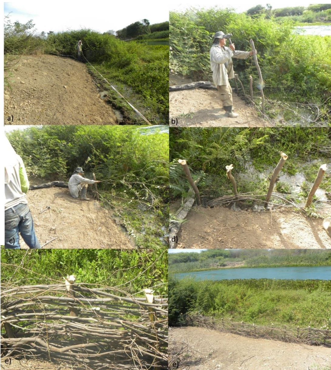
Figura 7 – Construção da obra de Trança viva às margem do rio São Francisco, na área de estudo em Belém de São Francisco – PE.
