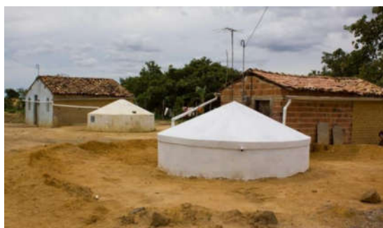
Figura 2. Cisternas de placas instaladas em residência na comunidade de Serra Grande, em Serra Talhada – PE. Fonte: Lima, 2014.
