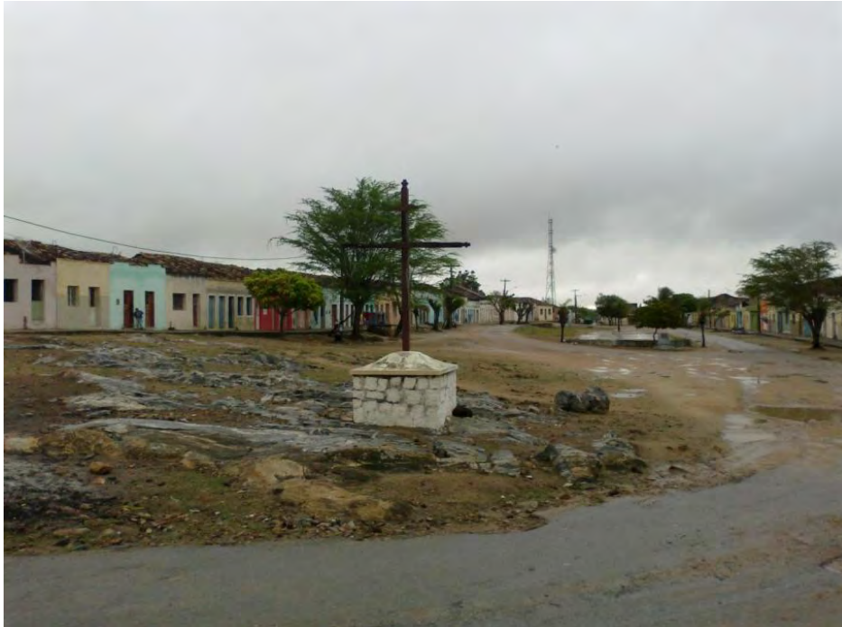
Foto 22 – Vista atual da Praça de Cimbres
