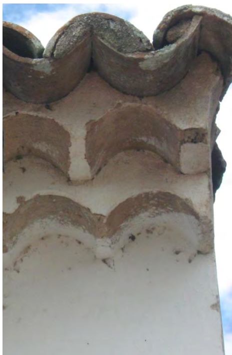
Foto 36 - Detalhe da tríplice telha
