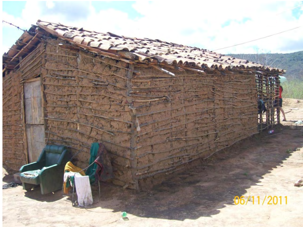
Foto 14 - Fachada de uma moradia feita de barro e madeira na comunidade quilombola do sítio Caldeirão
