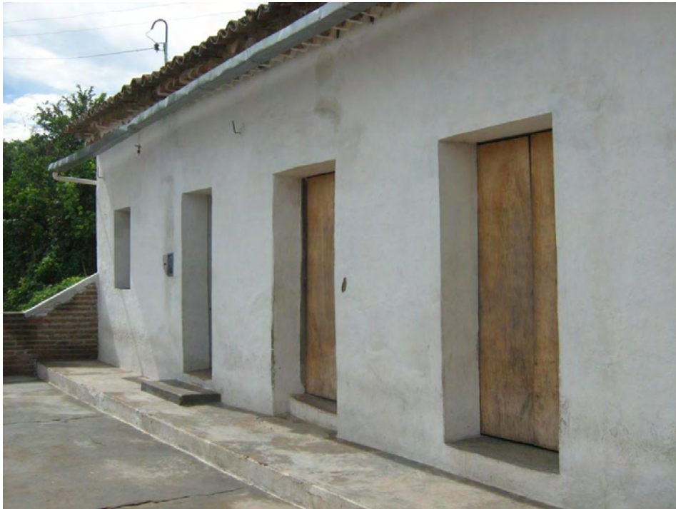
Foto 15 – Fachada do casarão do sítio Santa Rosa
