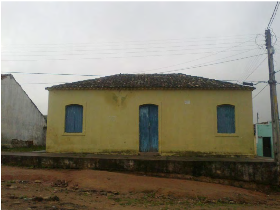
Foto 23 – Fachada da antiga casa do Senado da Câmara de Cimbres
