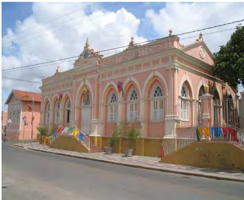
Foto: José Carlos Mendes – 08/03/2011 Prefeitura de Gravatá – construção de 1908
