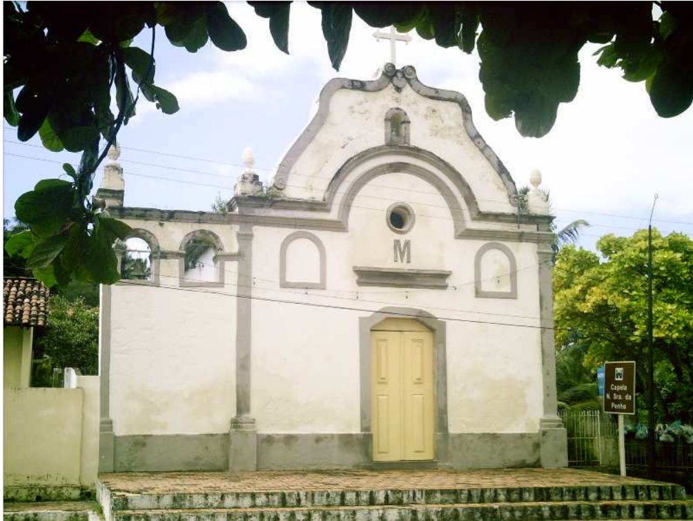
Foto 7: Igreja Nossa Senhora da Penha – Barra de Catuama - Goiana – Pernambuco SOTERO, 2008
