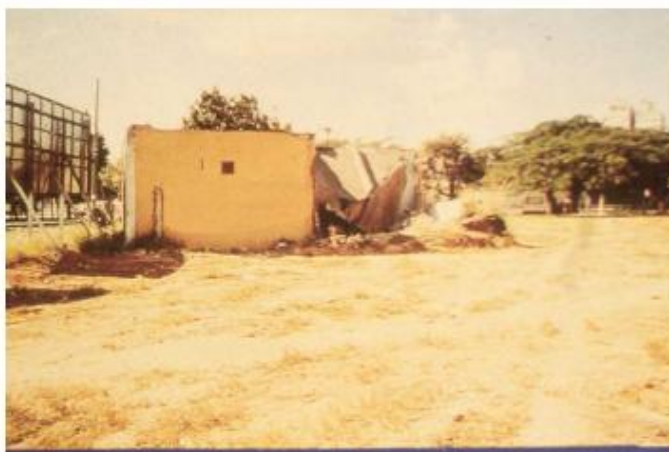
Figura 1 – Vista lateral do prédio do Instituto Goiano de Radioterapia. 34
