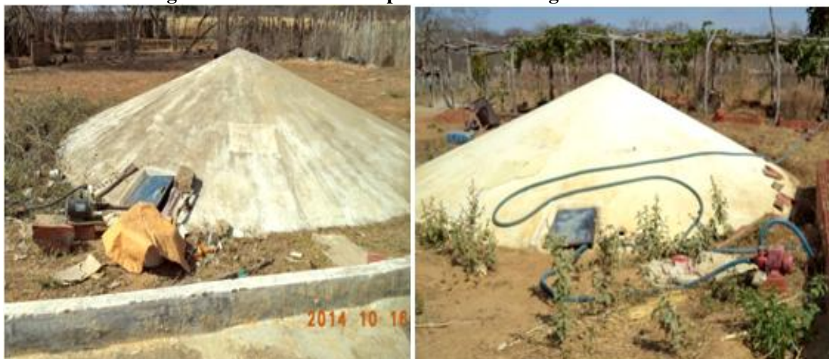
Figura 18 – Uso de bomba para retirada de água nas cisternas
