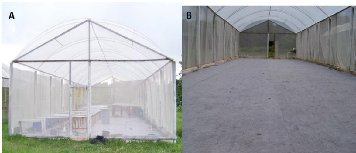
Figura 1 - Vista frontal da casa-de-vegetação (A); e Interior da Casa-de-Vegetação (B) onde foi conduzido o experimento.
