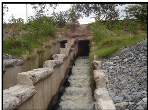
Figura 10: Esgoto doméstico lançado no rio Cuiabá
