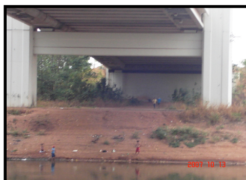
Figura 9: Ponte Ministro Sérgio Motta
