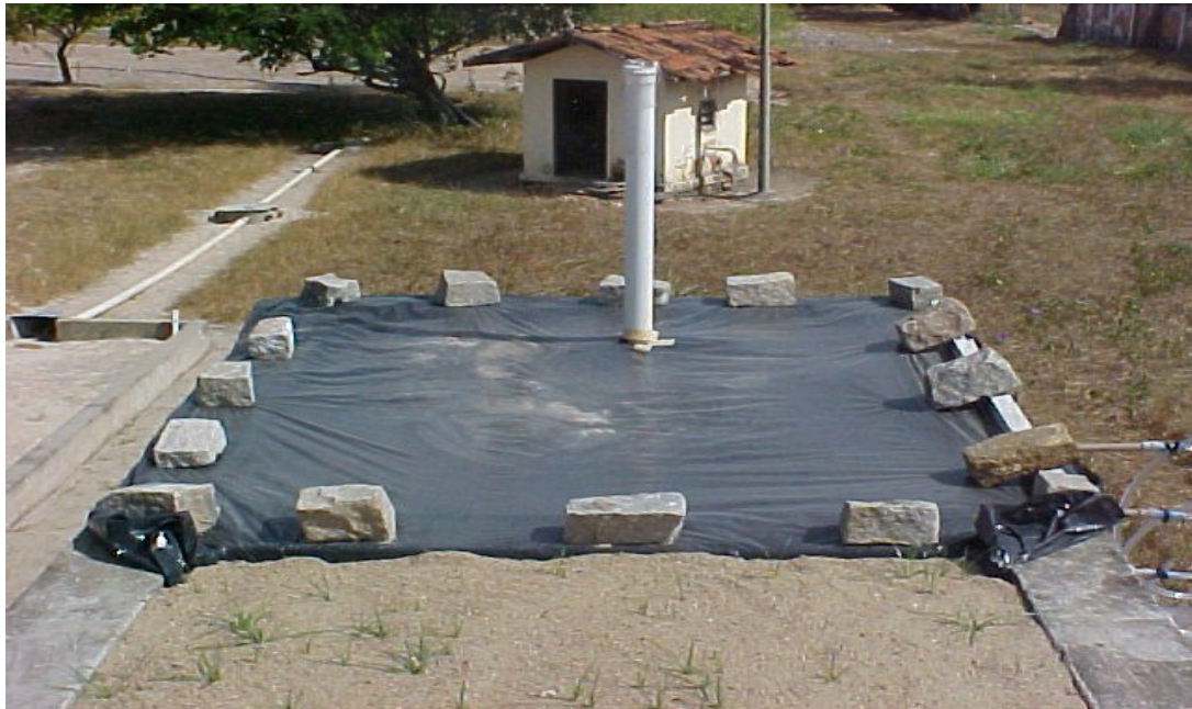
Figura 4. Tanque de drenagem com cobertura plástica na parte superior.
