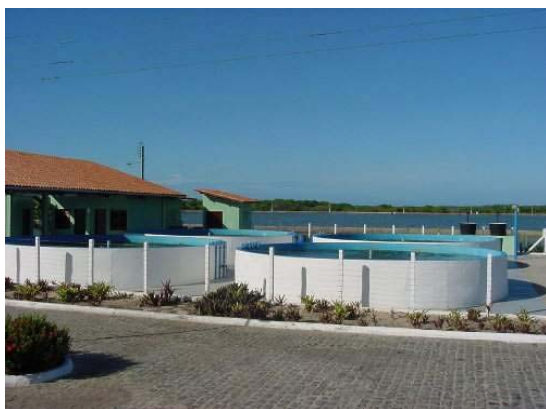
Figura 2 – Tanque berçário utilizado no cultivo do L. vannamei
