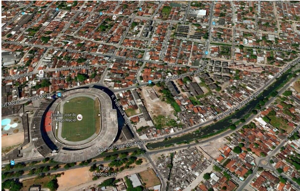
Figura 04: Vista aérea do local dos habitacionais sociais no bairro do Arruda.
