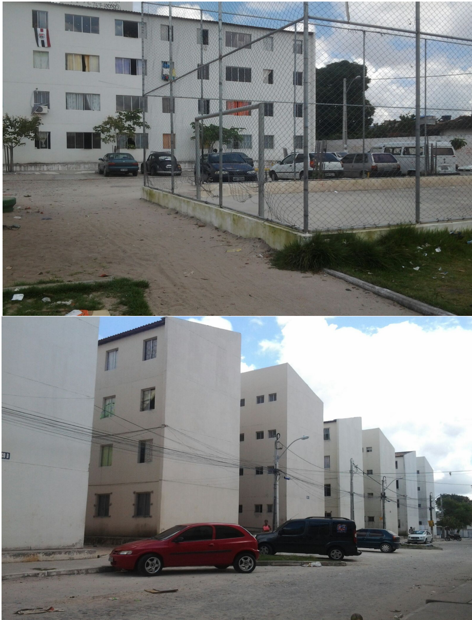
Figura 08: Estacionamentos dos habitacionais – PAC Beberibe
