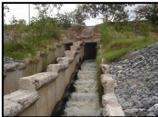
Figura 10: Esgoto doméstico lançado no rio Cuiabá
