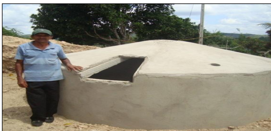
Figura 22: Cisterna sendo construída no PA União (2013). Arquivo: Rejane Ferreira (2013).
