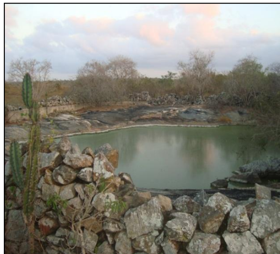
Figura 28 - Reservatório de água feito com pedras PA Celso Furtado. Arquivo: Rejane Ferreira( 2013).
