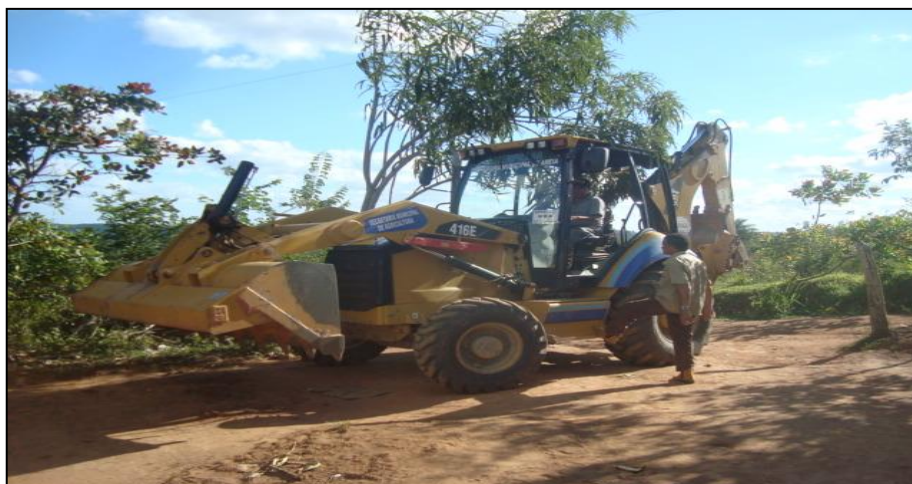
Figura 24: Máquina utilizada na construção de cisternas.
