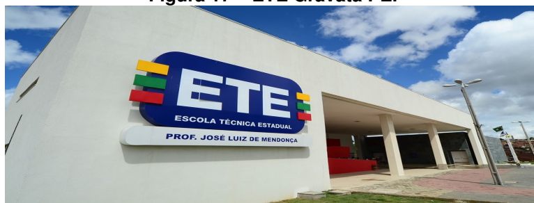
Figura 17 – ETE Gravatá PE.
