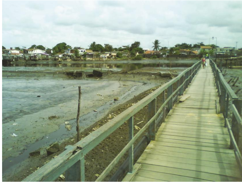
Figura 08: Ponte de Madeira da Ilha de Deus. Fonte: O autor, 2009.
