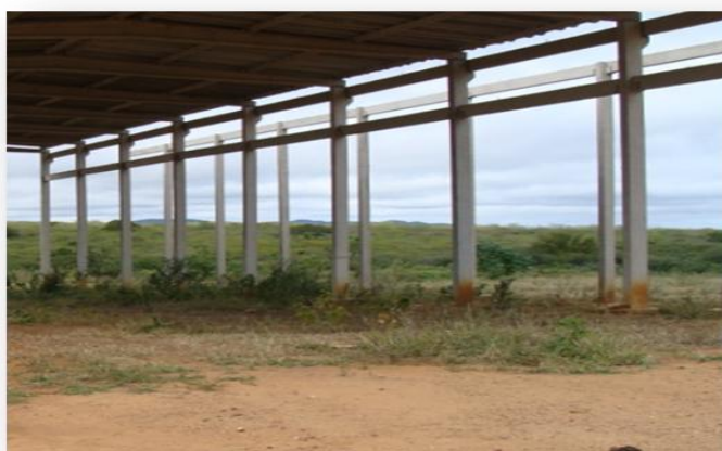
Figura 09- Obra Inacabada da Usina de Serra Talhada Fonte: Levantamento de Campo
