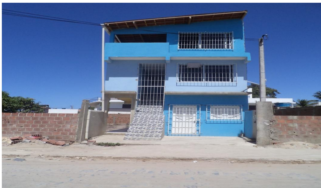
Imagem 26 - Construção de privês na Rua Salina Principal - Comunidade Pantanal
