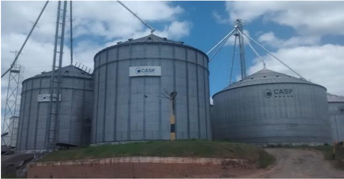
Fotografia 9 – Silos utilizados em fábrica de ração de uma integradora
