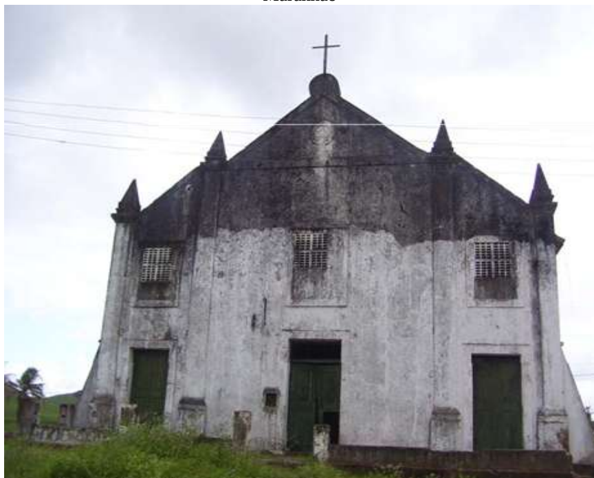
Foto 9 – Fachada da capela de Nossa Senhora da Penha, detalhe do seu frontão. Engenho Maranhão
