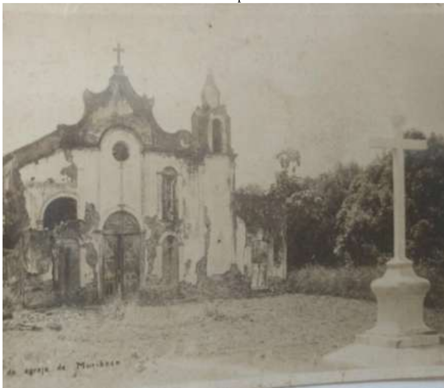
Imagem 15 – Fachada já em avançado processo de deterioração da Igreja de Nossa Senhora do Rosário dos Homens Pretos da então Freguesia da Muribeca, hoje pertencente ao município de Jaboatão dos Guararapes
