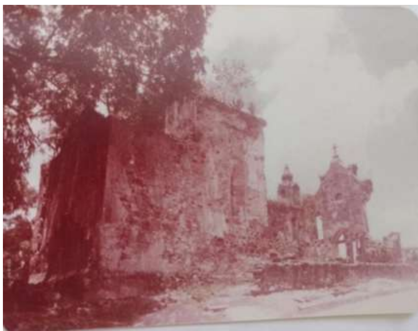
Imagem 18 - Vista da lateral esquerda e dos fundos da Igreja de Nossa Senhora do Rosário dos Homens Pretos da então Freguesia da Muribeca, hoje pertencente ao município de Jaboatão dos Guararapes
