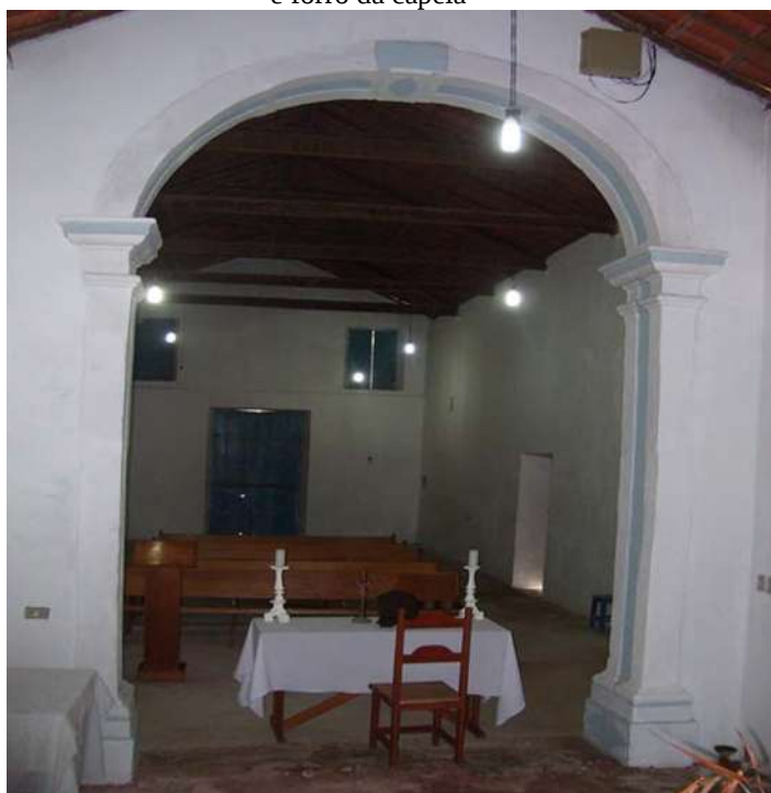
Foto 8 – Vista do interior da capela, a partir do altar-mor da nave. Detalhe do local onde havia o coro e forro da capela
