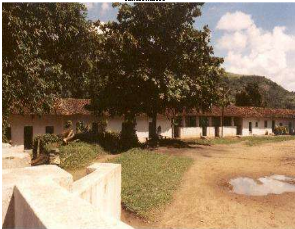
Imagem 25 – Senzala do Engenho Campestre, atualmente utilizada como residência dos funcionários
