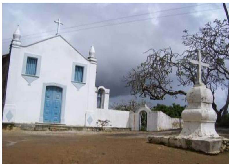
Foto 3 – Capela de Nossa Senhora da Conceição dos Outeiros de Maracaípe, município de Ipojuca (PE)
