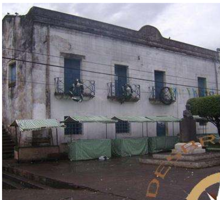
Foto 1 - Prédio onde funcionou a Casa de Câmara e Cadeia da Vila Formosa de Sirinhaém, datado do século XVIII, município de Sirinhaém (PE).
