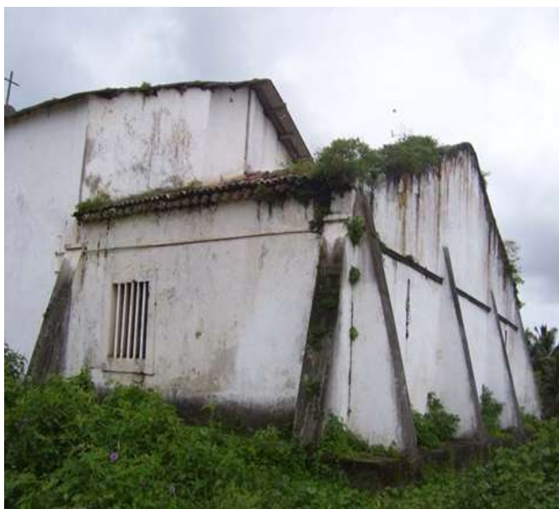
Foto 11 – Área posterior à nave, onde está localizada a sacristia e os túmulos; detalhe dos contrafortes
