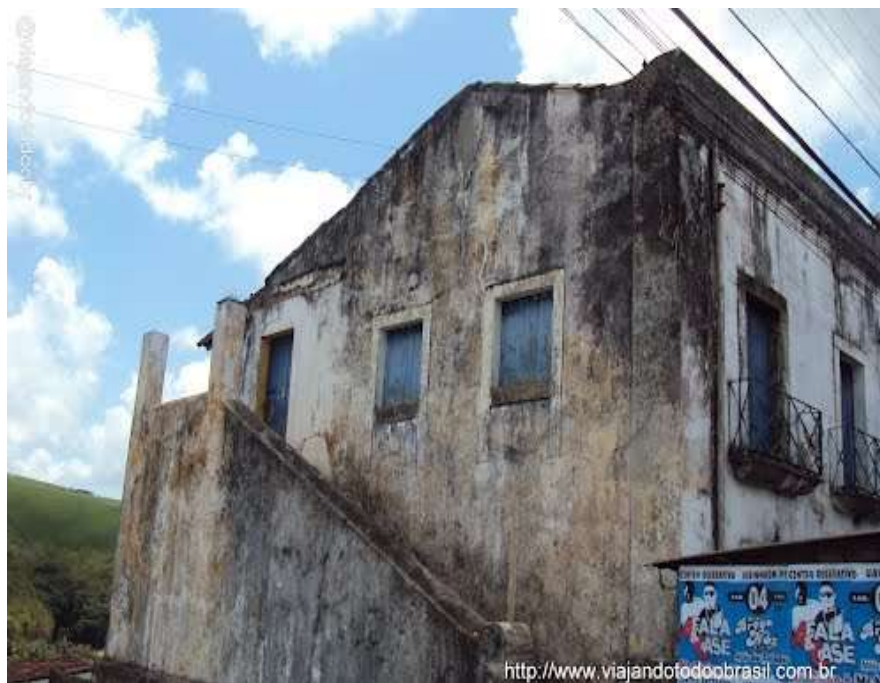
Foto 2 - Lateral esquerda da escada externa que dá acesso ao pavimento superior do prédio onde funcionou a Casa de Câmara e Cadeira da Vila Formosa de Sirinhaém, datado do século XVIII, Município de Sirinhaém – PE.
