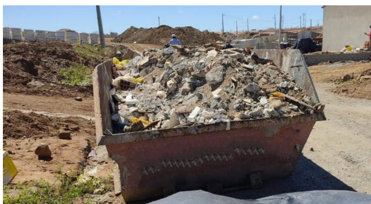
Figura 18 - Acondicionamento de resíduos no canteiro de obra B.
