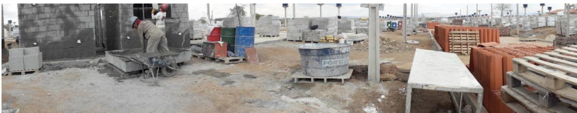
Figura 10 - Frente de serviço para execução da etapa de alvenaria na obra A.
