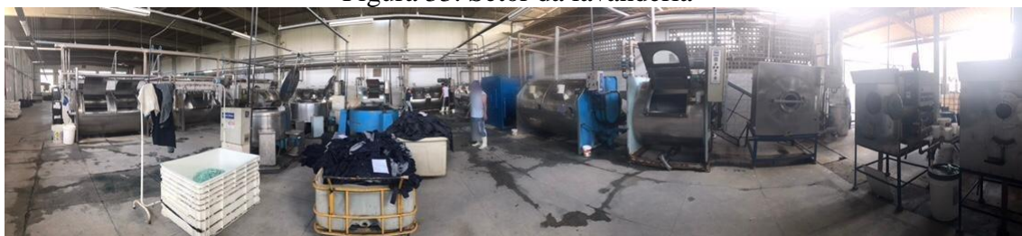
Figura 33. Setor da lavanderia
