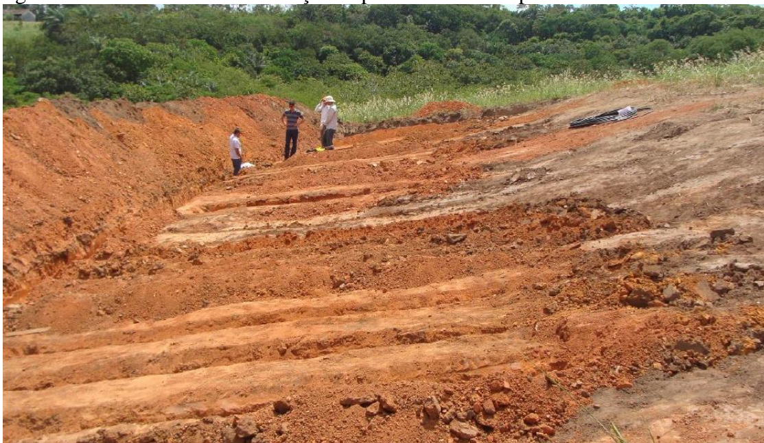
Figura 4. Canal construído na Estação Experimental de Carpina-PE.
