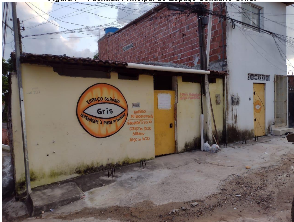
Figura 7 - Fachada Principal do Espaço Solidário GRIS.
