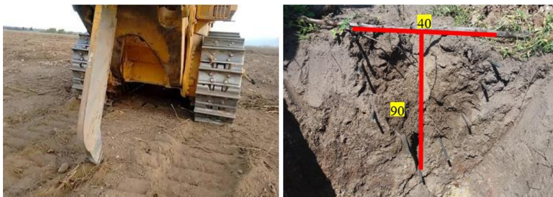
Figura 3. Haste do Ripper de subsolagem e estouramento da subsolagem realizada na área experimental na Fazenda Lagoa Grande, localizada no município de Glória do Goitá, Pernambuco, Brasil.
