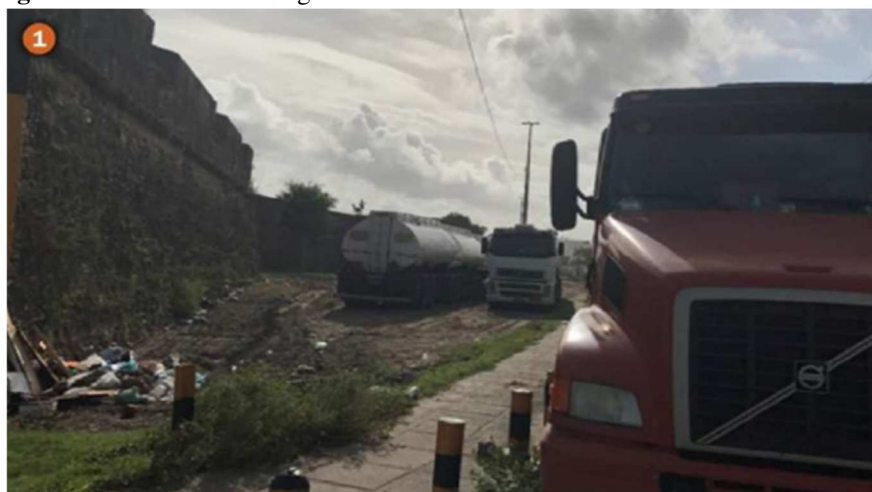
Figura 14 – Vista da Av. Augusto Chericate em frente à Fortaleza de Santa Catarina.
