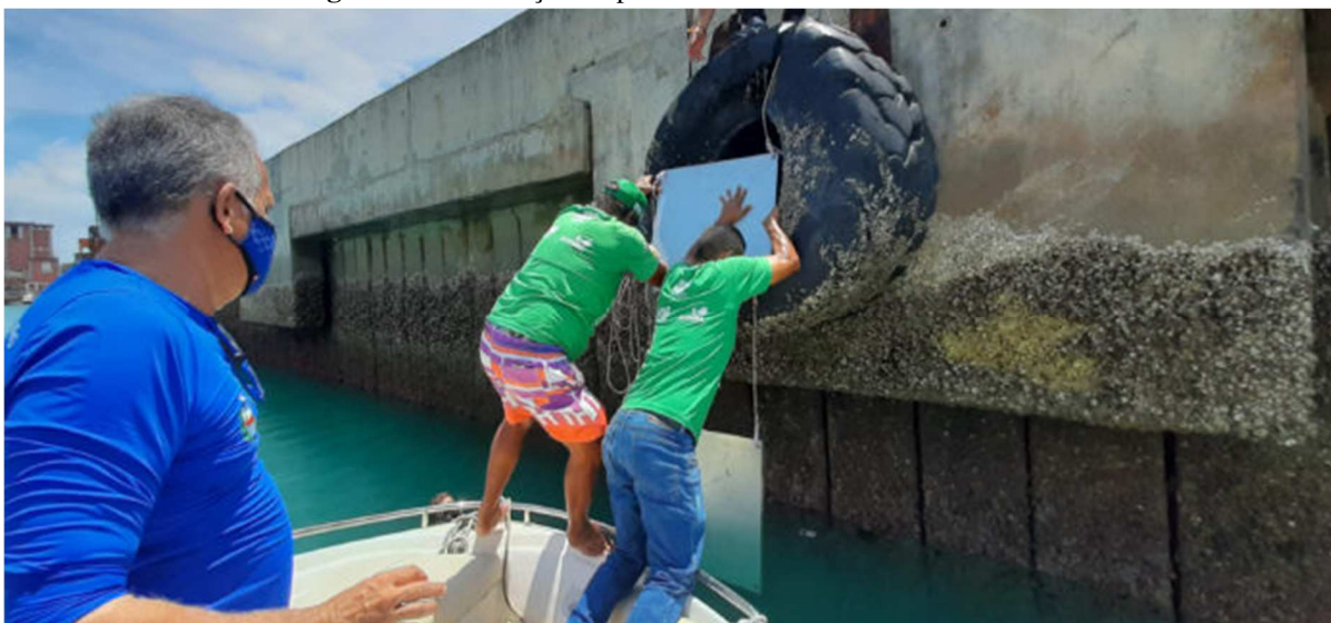
Figura 16 – Instalação de placas de metal no Porto de Maceió.
