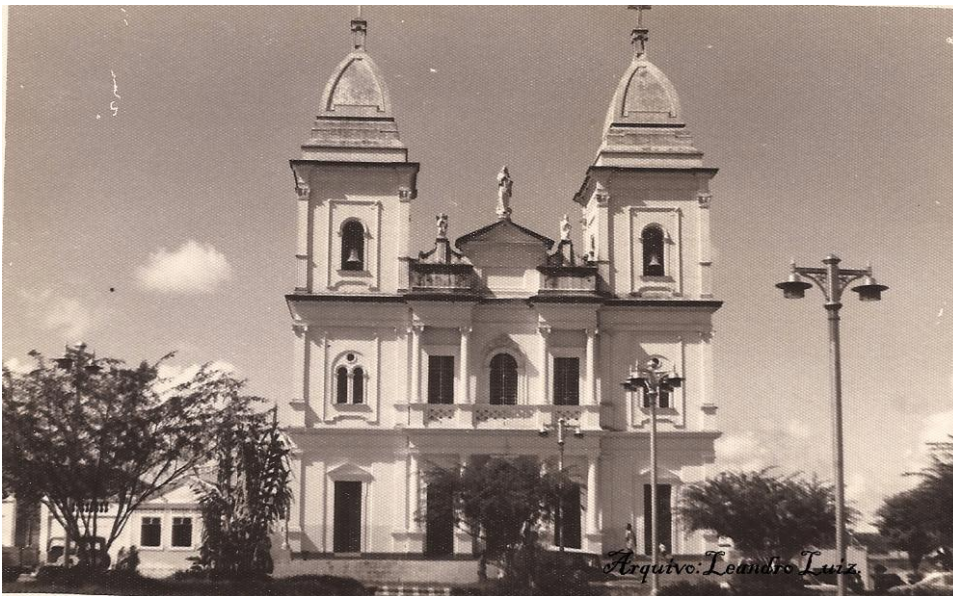
Figura 1 - Igreja Catedral - Nossa Senhora da Conceição, localizada na Praça João XXIII, antiga Praça João Pessoa.
