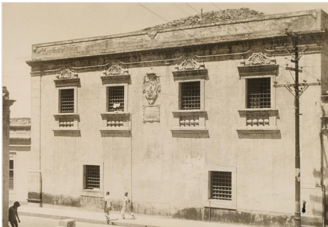
Figura 13 – Fachada da casa na Rua Treze de Maio, Aljube, 1951. Fonte: Acervo Digital IPHAN
