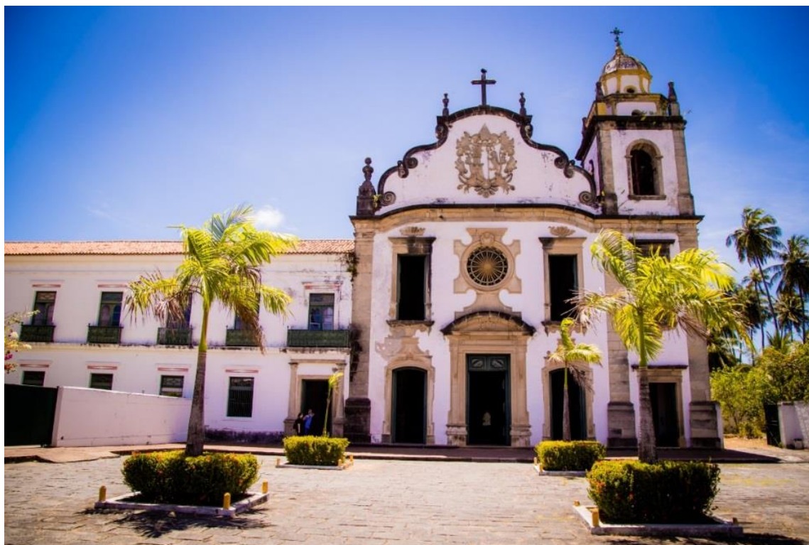
Figura 6 – Frontispício feito em cantaria do Mosteiro de São Bento de Olinda.
