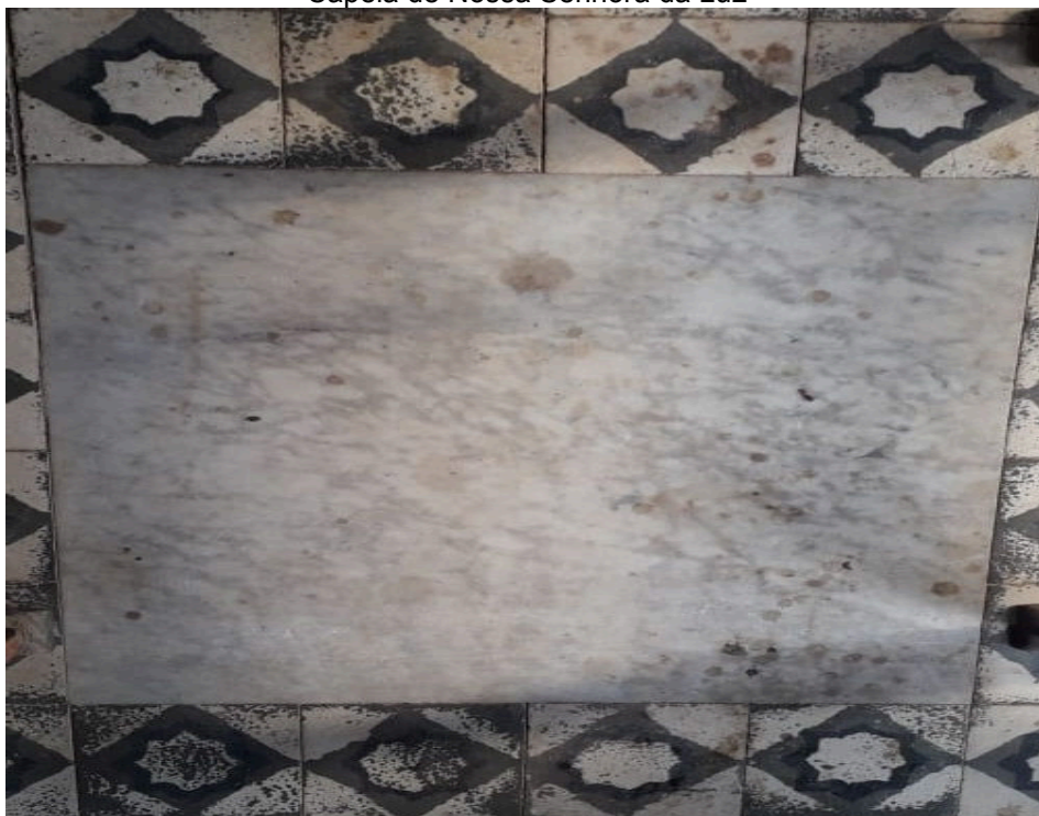
Figura 57 – Fotografia da placa do suposto aterramento na entrada da Capela de Nossa Senhora da Luz
