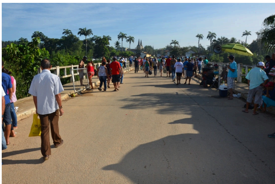
Figura 45 – Fotografia da ponte de acesso a Capela de Nossa senhora da Luz
