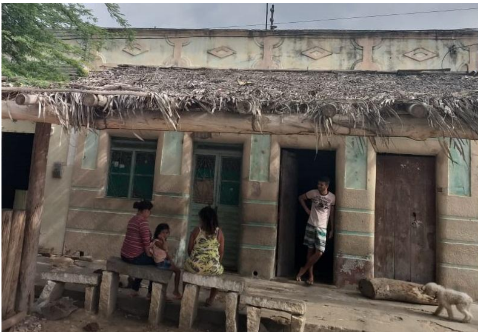
Foto 08: Visão externa da casa onde encontra-se a cruz rabiscada no portal. Ana Lúcia Lira
