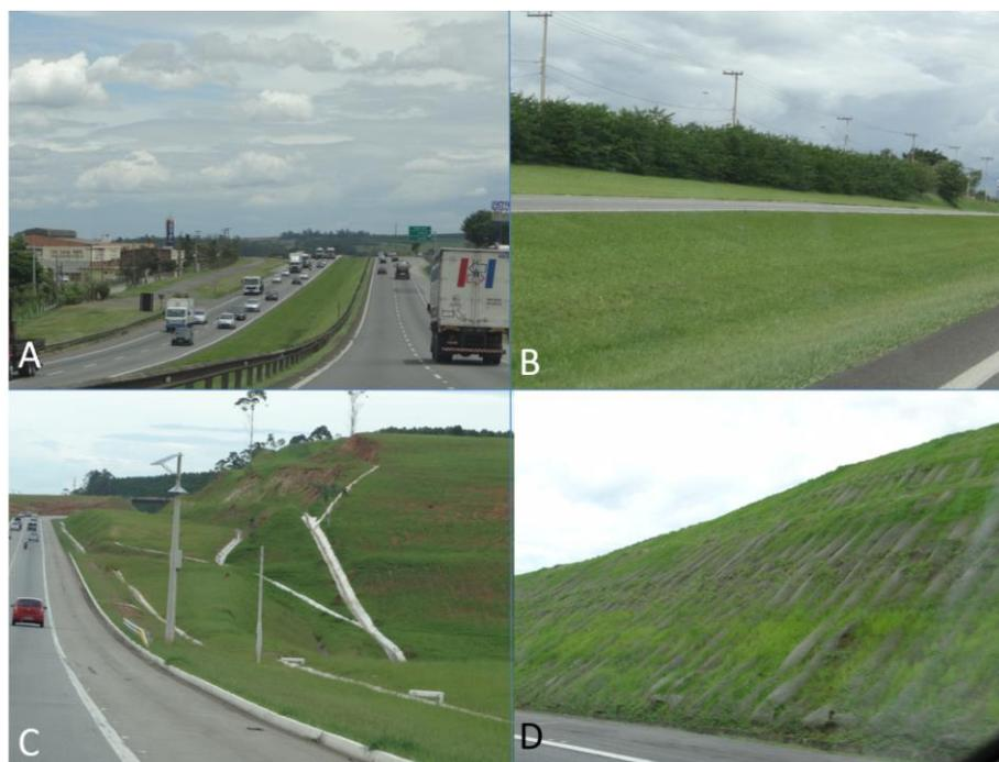
**Figura 2.** Gramados funcionais: a margens de estradas e rodovias (A; B); em cortes e aterros (C); e recobrimento protetivo de encostas (D). Fotos: Vivian Loges. Fonte: Silva (2015).
