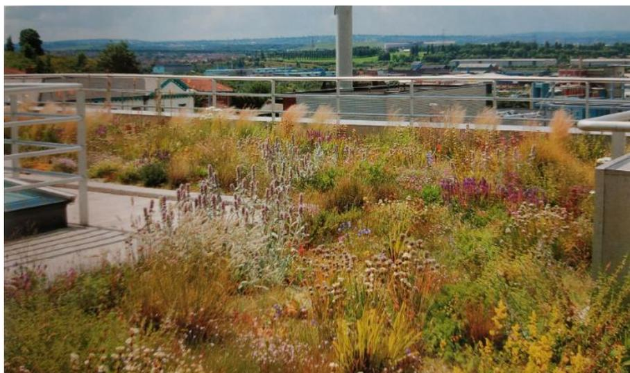
**Figura 6.** Telhado verde semi-extensivo no Centro Empresarial Moorgate Crofts, Rotherham, Reino Unido, não é irrigado ou fertilizado, tem uma profundidade de substrato de 10-20 cm, é de baixa manutenção e rico em biodiversidade vegetal e animal. Fonte: Dunnet e Kingsbury (2010).
