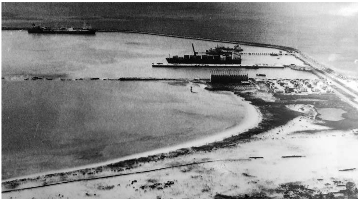
Figura 4 – Registro fotográfico do primeiro navio a atracar no porto de Suape.
